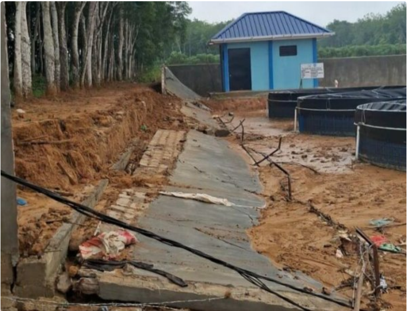
Pagar pembatas Balai Benih Ikan Air Tawar (BBIAT) di Desa Buko Poso Roboh
